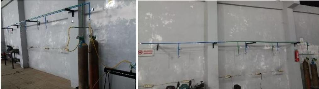
Gambar 8. Sistem instalasi pipa udara dan gas O<sub>2</sub>
