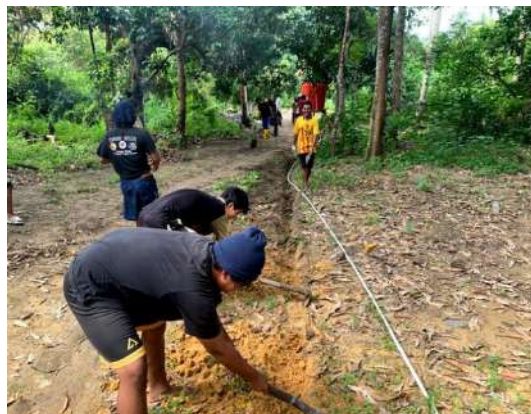
Gambar 3. Proses penggalian daerah pipa distribusi air bersih
