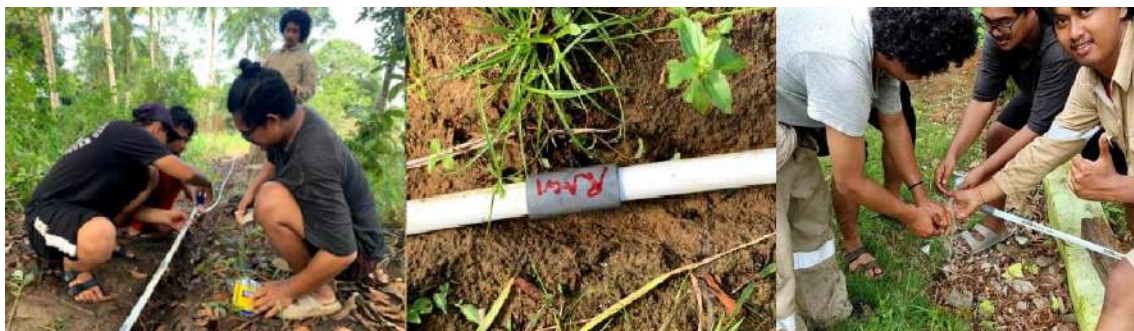
Gambar 6. Instalasi distribusi air dan penentuan titik alir ke rumah warga
